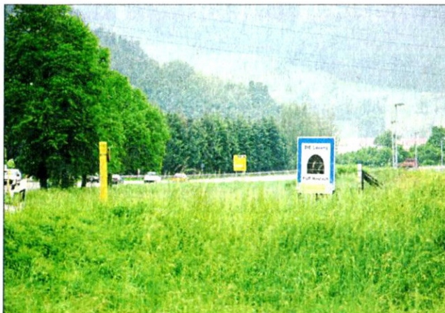
Seit Jahren fordert Haslach bei der B33-Umfahrung eine Tunnellösung, vor allem im Hinblick auf die Gefahren im Überschwemmungsgebiet.
